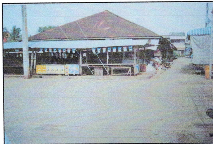
ภาพที่ ๑ : แสดงอาคารตลาดสดหลังเก่า (อาคารไม้) ก่อนการปรับปรุงก่อสร้าง
