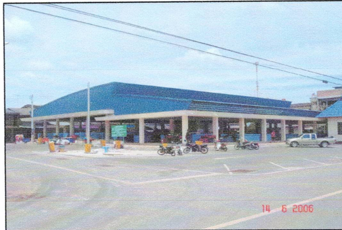
ภาพที่ ๔ : แสดงอาคารตลาดสดเทศบาลฯ หลังใหม่ที่ดำเนินการก่อสร้างปรับปรุงเสร็จแล้ว
