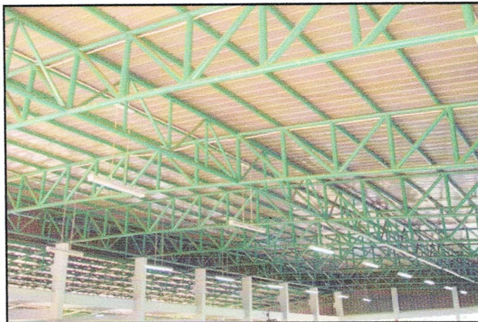
ภาพที่ ๑ : แสดงโครงสร้างหลังคา และแสงสว่างภายในอาคารตลาดสดเทศบาลฯ
